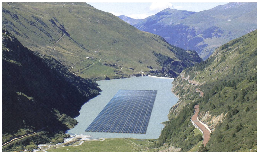
Figure 4 Le projet à grande échelle de parc solaire flottant s'étendrait sur 35 % de la superficie du lac des Toules.
