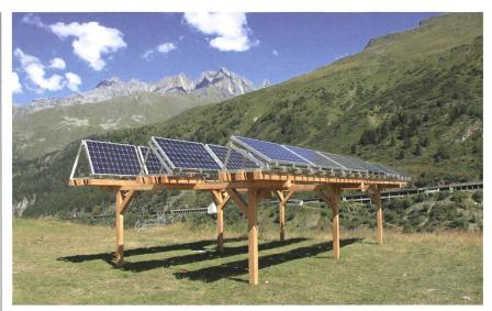
**Figure 1** Structure pilote installée à proximité du lac des Toules afin de déterminer l'angle d'inclinaison optimal et la technologie de panneaux la mieux adaptée au site.
