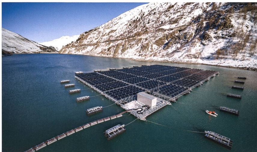
Figure 3 Le parc de démonstration est composé de 36 structures flottantes supportant, outre un onduleur et un transformateur, 1400 panneaux photovoltaïques bifaciaux.
