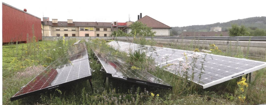
Bild 1 Der Bewuchs auf Gründächern kann zu einer nachteiligen Abschattung der PV-Anlage führen. Wartungsarbeiten werden wiederum durch eine dichte Belegung mit PV-Modulen erschwert.
