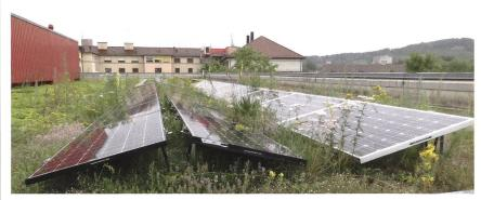
**Bild 1** Der Bewuchs auf Gründächern kann zu einer nachteiligen Abschattung der PV-Anlage führen. Wartungsarbeiten werden wiederum durch eine dichte Belegung mit PV-Modulen erschwert.
