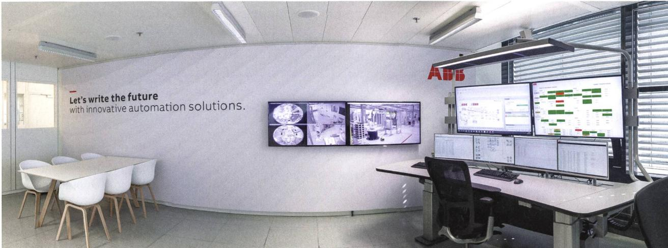
Im Steuerungsraum werden Informationen für die Steuerung der Produktion zusammen mit Live-Stream-Bildern im HMI dargestellt. Dies ermöglicht es einer Person, die gesamte Produktion zu steuern.
