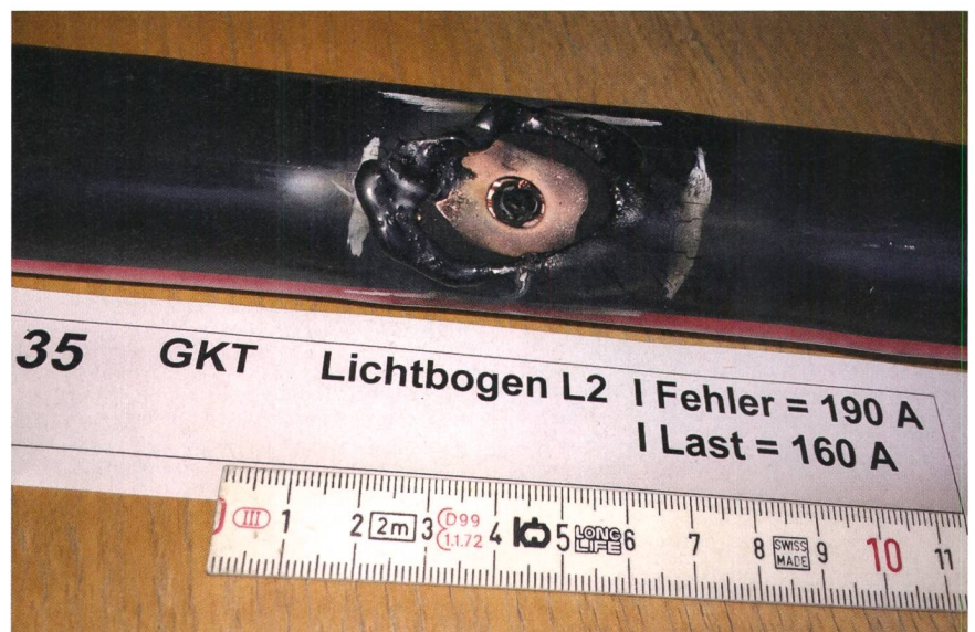
Bild 3 Fehlerstelle eines durch den Erdschluss beschädigten Versuchskabels.
