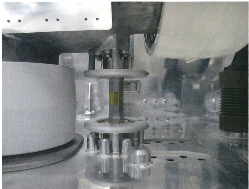
Bild 3 Erdungsschalter in einem Generatorleistungsschalter in geschlossener Position. Der bewegliche Stift verbindet die oberen und unteren Tulpenkontakte.
