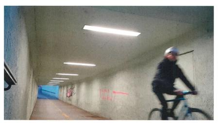
Ce passage souterrain du quartier Enge de la ville de Zurich est équipé de tubes LED qui ne fonctionnent à leur intensité maximale qu'en présence de cyclistes ou de piétons. Dès que le cycliste a traversé le passage souterrain, les luminaires réduisent leur puissance à 20 %.
