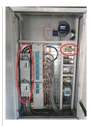
**Bild 3** Linker Kreis: Kuppelschalter 400 A. Rechter Kreis: Netzüberwachung. Dieser NA-Schutz ist gleich teuer wie der gesamte Rest der Unterverteilung.
