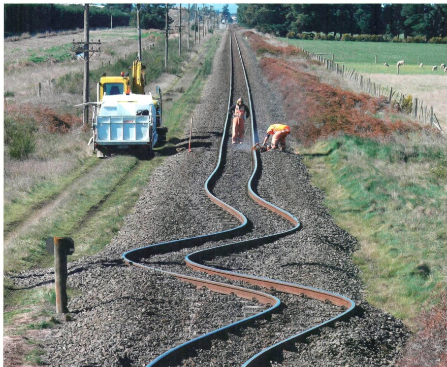
Bild 7 Ob durch Erdbeben oder Ausdehnung unter Wärmeeinfluss, Schienen können manchmal spektakuläre Verformungen erfahren.
