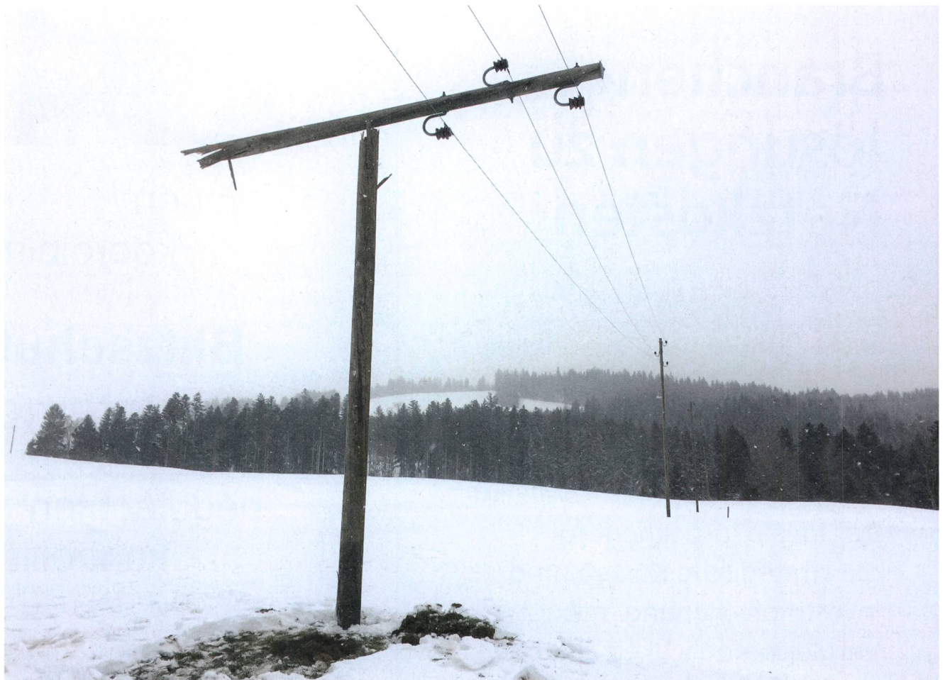
Ein Mast bei Oberägeri, der in der Nacht vom 2. auf den 3. März 2016 von einer Westwind-Bö geknickt wurde.
