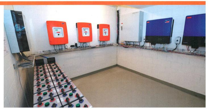
Batteries, redresseurs et onduleurs.
