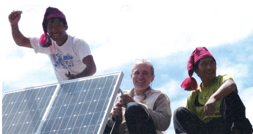
Privilégier les énergies renouvelables et impliquer la population locale: deux conditions indispensables pour assurer la durabilité des projets.
