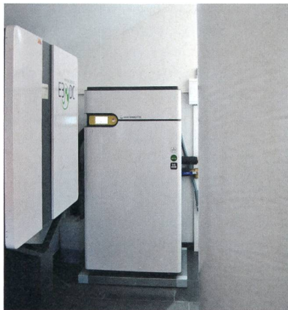
Das Hauskraftwerk (links im Bild) steuert im Solarhaus die Wärmepumpe und die Wallbox an.
