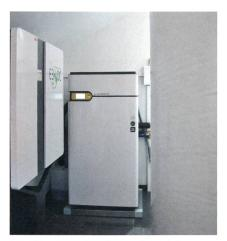
Das Hauskraftwerk (links im Bild) steuert im Solarhaus die Wärmepumpe und die Wallbox an.
