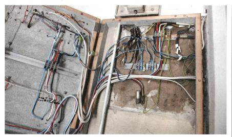
**Figure 3** Tableau de répartition sans protection pour les doigts (IP2X). Attention : se pose également ici le problème de l'amiante.
