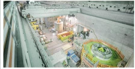
**Figure 2** La caverne des machines contient six pompes-turbines de dernière génération de 150 MW chacune.
