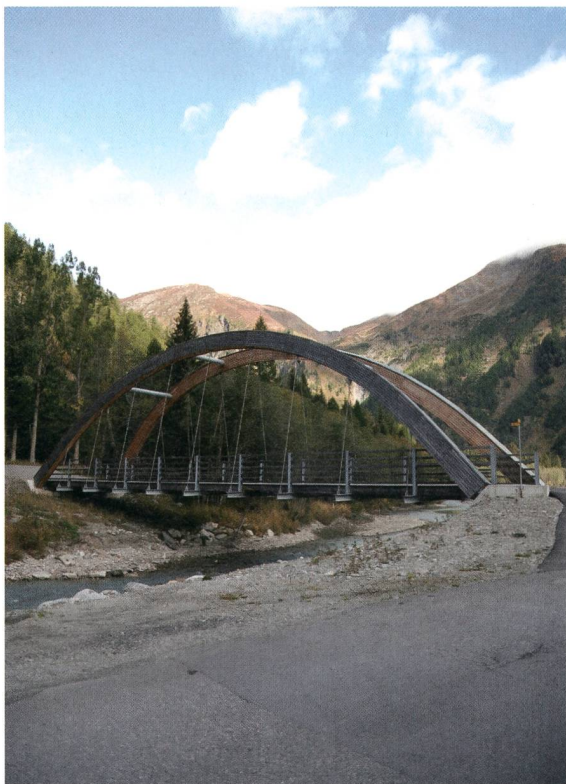
Le nouveau pont pour piétons faisait partie des mesures supplémentaires.
