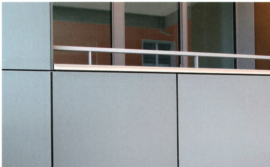
Bild 1 Unsichtbare Photovoltaik in aktiver Glasfassade.
