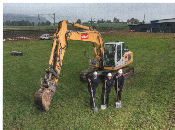
Spatenstich zum neuen CKW-Werkhof.
