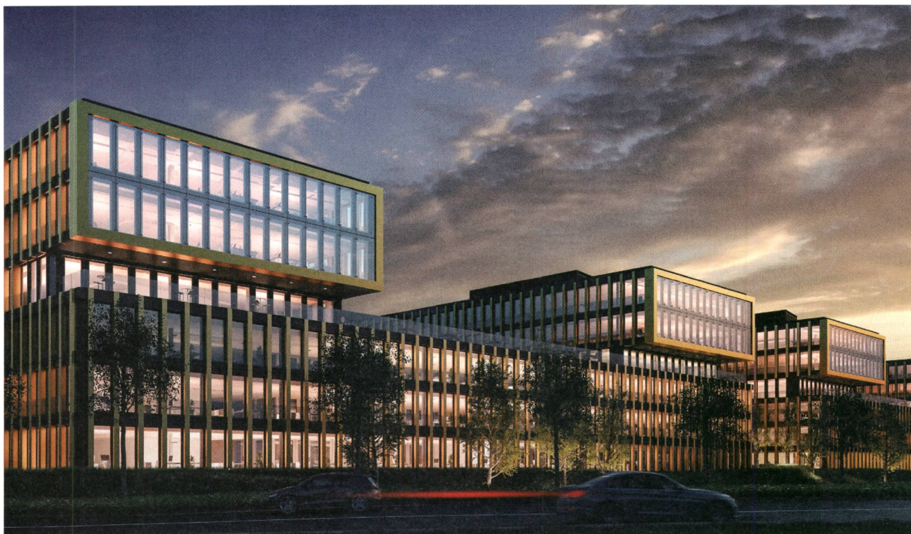
Hocheffiziente LED-Leuchten und intelligente Steuerung: Trivalite im Quadrolith-Bürokomplex in Baar.
