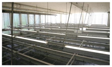
Das «Davoser Kaltdach» des Kirchner-Museums leitet das Tageslicht in die Ausstellungsräume. Die Fluoreszenzröhren unterstützen das Tageslicht bei Bedarf. Mit den Lamellenstoren lässt sich das Tageslicht «dimmen».
