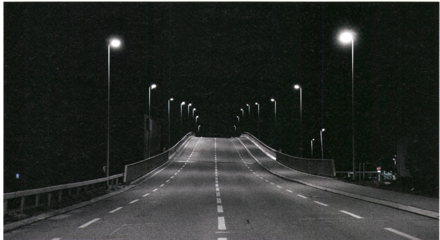
Bild 1 Neue Beleuchtung einer Hauptstrasse in Delémont.
