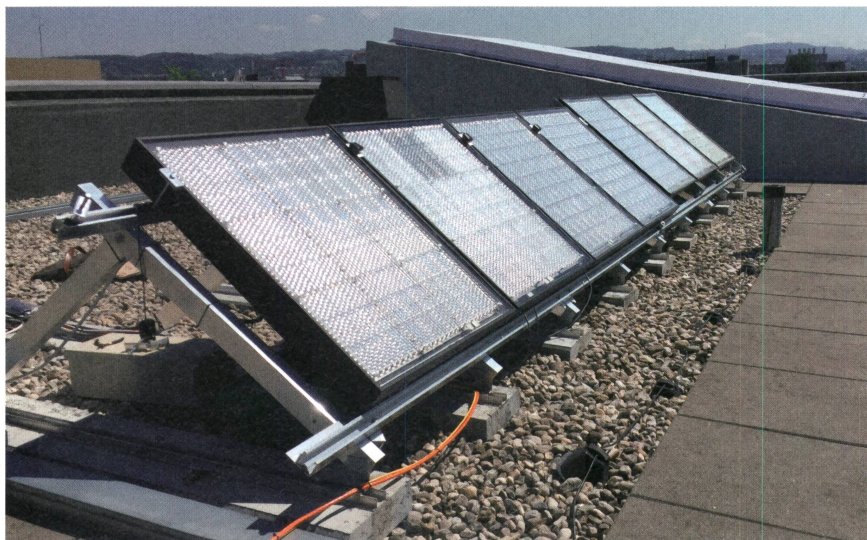
Figure 2 Installation pilote de modules Insolight à l'EPFL.
