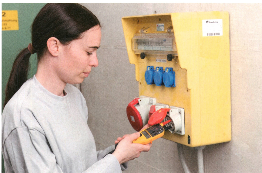
Bild 4 Messung bei einer Steckdose IP2X ohne PSA.
