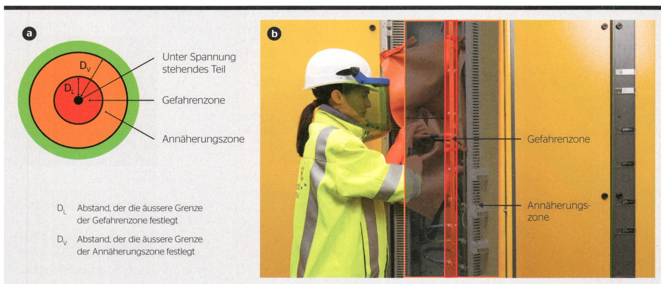
Bild 5 Annäherungszone ohne Abdeckung (Arbeitsmethode 2)
