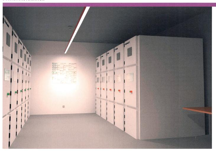
Rendering eines Mittelspannungsraums.
