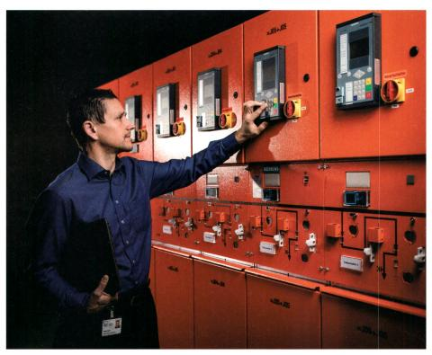
Daniel Hauri, Leiter Technik und Sicherheit des SPZ, prüft die Mittelspannungsanlage von der Siemens, Typ 8DJH.
