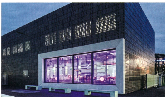
Das EWZ-Unterwerk in Zürich Oerlikon macht moderne Energietechnologien sichtbar.
