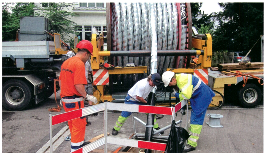
Bild 4 Kabeleinzug des ersten 150-kV-Dreileiterkabels im Jahr 2014.
