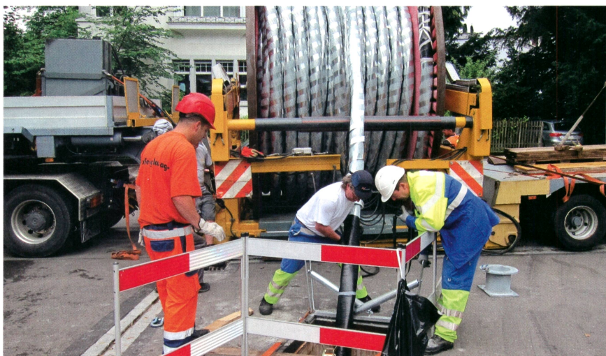
Bild 4 Kabeleinzug des ersten 150-kV-Dreileiterkabels im Jahr 2014.
