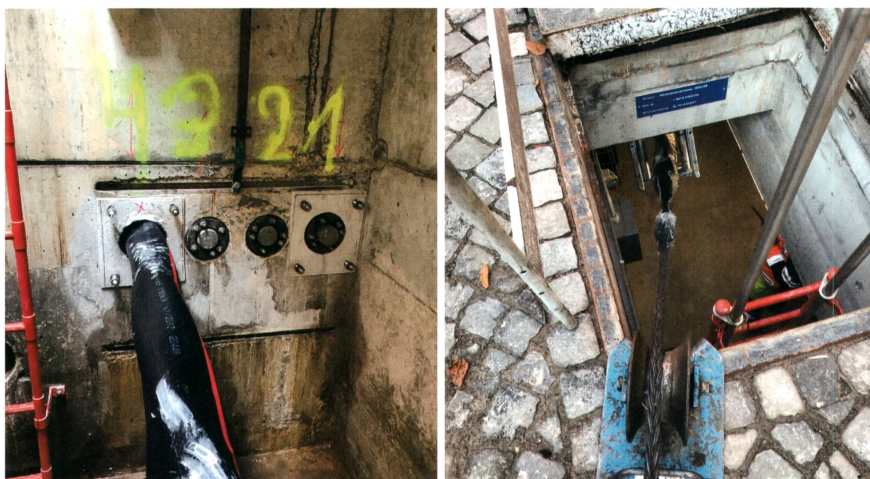
Bild 1 Eingezogenes 150-kV-Dreileiterkabel in bestehendem Kabelschutzrohr durch Muffenschacht.
