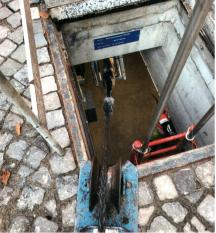
**Bild 1** Eingezogenes 150-kV-Dreileiterkabel in bestehendem Kabelschutzrohr durch Muffenschacht.
