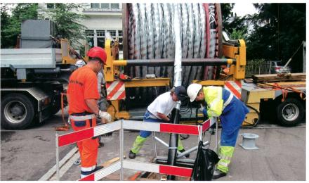
Bild 4 Kabeleinzug des ersten 150-kV-Dreileiterkabels im Jahr 2014.
