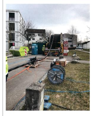
**Bild 3** Spezieller Verlegewagen mit Kabeltrommel für ein 150-kV-Dreileiterkabel mit einer Länge von 800 m.
