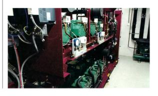
Figure 2 Compresseurs pour la production de chaud et de froid industriel.
