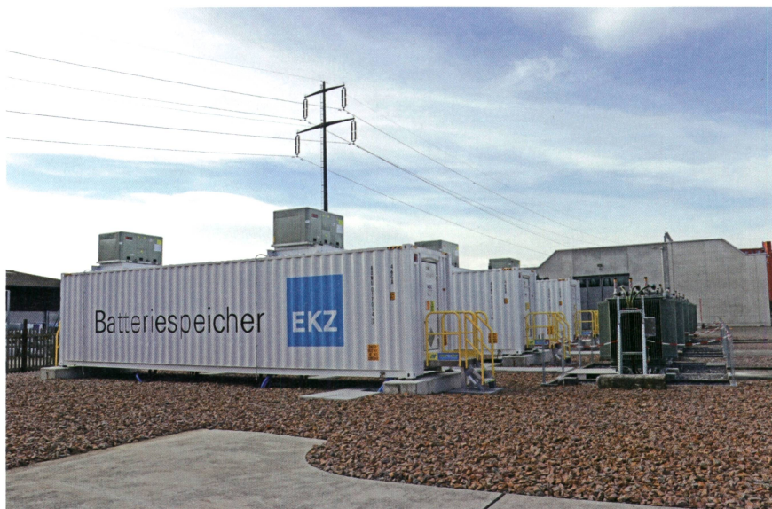
Der Batteriespeicher der EKZ steht in Volketswil und verfügt über eine maximale Leistung von 18 MW.
