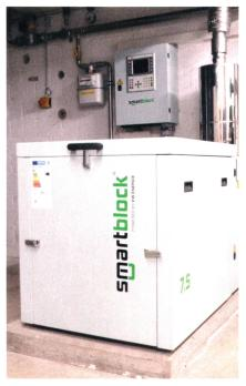
**Bild 5** Smartblock-BHKW mit 7,5 kW elektrischer und 22,1 kW thermischer Leistung, im Heizraum inklusive Abgaskondensator.
