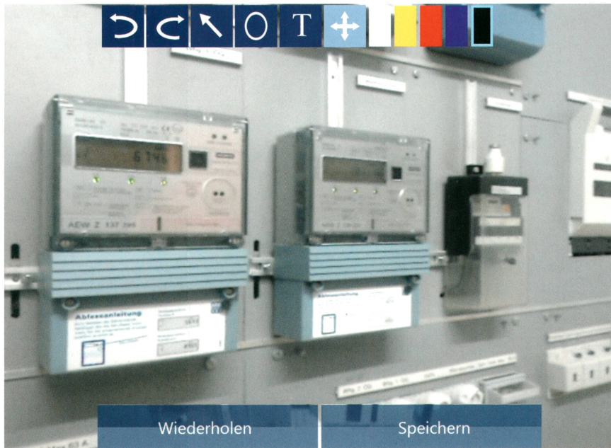
Bild 5 Bilddokumentation der Vorort-Installation.
