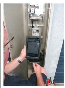
**Bild 4** Parametrierung der Relais.
