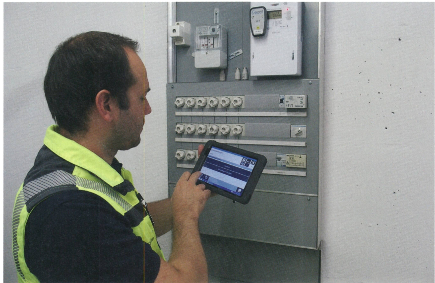
Bild 3 Ablesung des neuen Zählers via Bluetooth nach der Montage.
