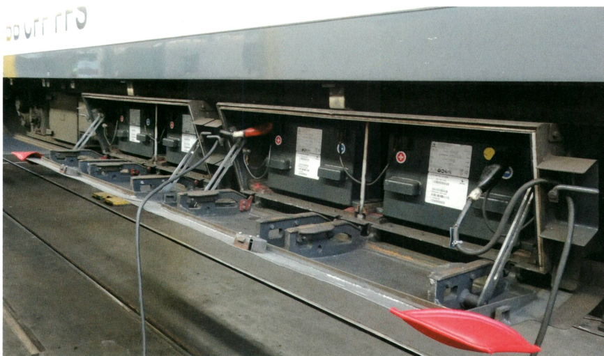
Der Reisezugwagen EW4 führt zwei parallele 36-V-Batteriestränge mit, aktuell in vier Trögen mit je einer 18-V-Bleibatterie untergebracht.
