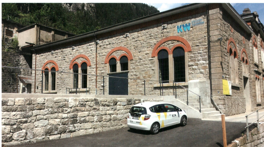
Das markante Gebäude des Kraftwerks Gurtellen: aussen denkmalgeschützt – innen moderne Technik.
