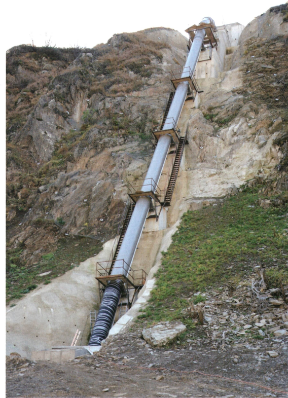
Druckleitung aus Stahl während der Bauphase. Die Treppen und Hilfskonstruktionen wurden anschliessend entfernt.
