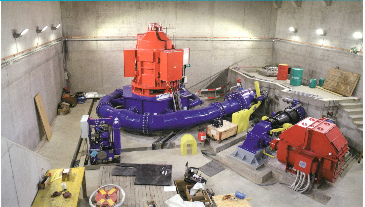
Maschinenhalle während den Installationsarbeiten: Pelton-Turbine (links) und Ossberger-Turbine. Die Wasserkomponenten sind blau, die Generatoren rot.
