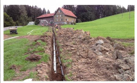
Erdverlegte Kabelleitungen müssen lückenlos dokumentiert sein, um Beschädigungen durch Grabungsarbeiten zu verhindern.
