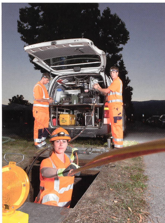
Netzelektriker mit Schwerpunkt Telekommunikation bei der Verlegung von Lichtwellenleiterkabeln.
