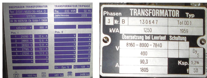
Bild 2 Auf dem Typenschild eines Trafos ist die Kurzschlussspannung in % der Nennspannung angegeben, z.B. Kurzschlussspannung von 5,3%.
