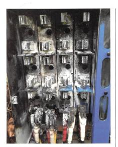
**Bild 6** Durch Kurzschluss beschädigte Schaltgerätekombination ohne korrekte Schutzauslösung.
