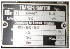
**Bild 2** Auf dem Typenschild eines Trafos ist die Kurzschlussspannung in % der Nennspannung angegeben, z.B. Kurzschlussspannung von 5,3%.
