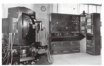
**1957** Von ETH und TTC entwickeltes Kernresonanz-Spektrometer KIS1, ausgerüstet mit Permanentmagnet.
