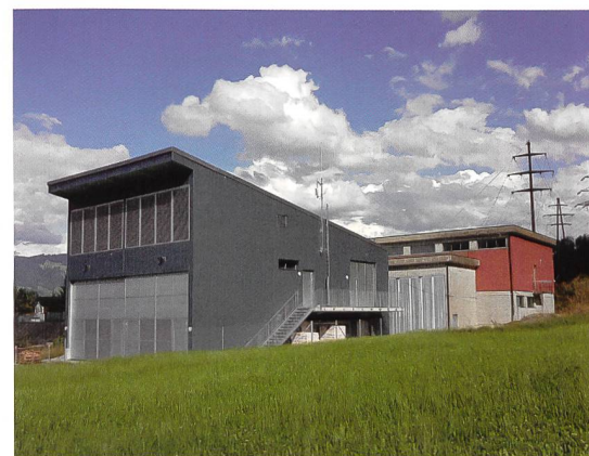
Die Unterstation geht 2018 in Betrieb.
