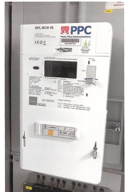
Ein Smart Meter mit BPL-Kommunikation.
