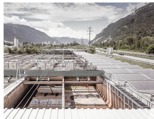
Das Solarfaltdach über der ARA in Chur.
