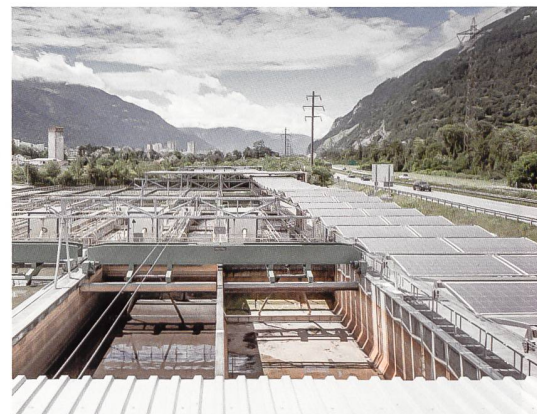
Das Solarfaltdach über der ARA in Chur.
