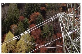
Neuer Gittermast mit 380-kV-lsolatorenkette (oben) und Seilschwingungsdämpfer (unten) von Pfisterer.
