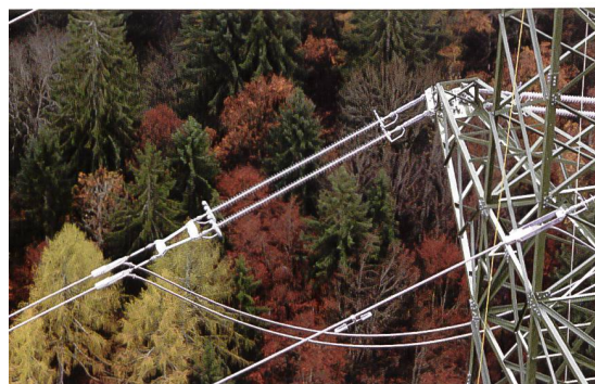
Neuer Gittermast mit 380-kV-Isolatorenkette (oben) und Seilschwingungsdämpfer (unten) von Pfisterer.
