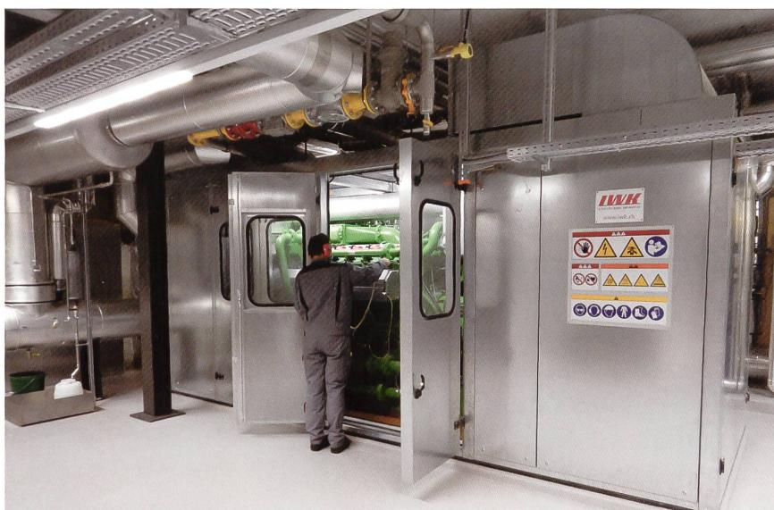
**Bild 4** Das Blockheizkraftwerk der ARA Morgental in Steinach (SG) produziert aus Klärgas elektrische Energie. Die ARA nimmt am Alpiq-Regelleistungspool teil.
