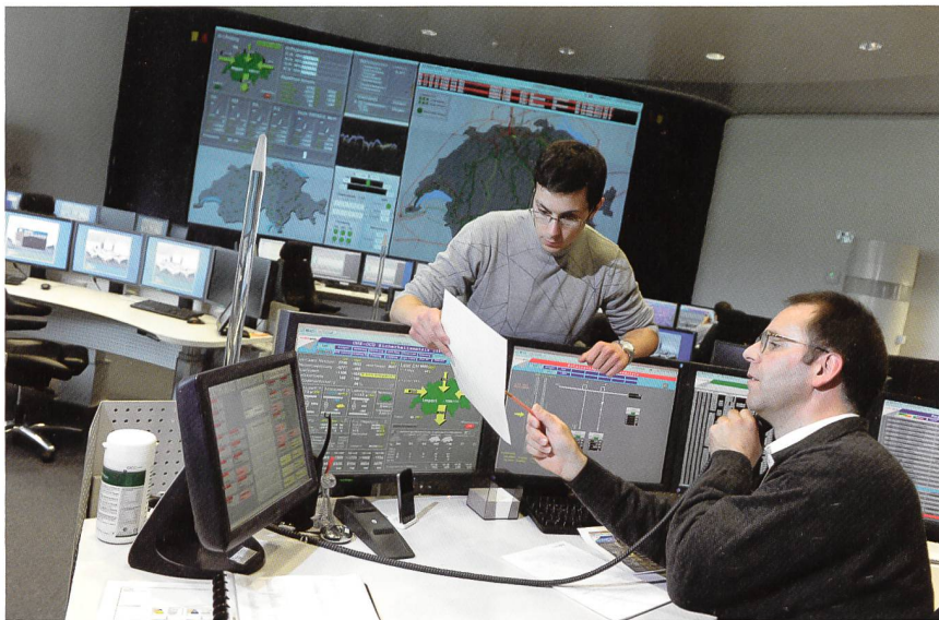
Bild 3 Die Dispatcher von Swissgrid überwachen das Schweizer Stromnetz permanent und halten es durch ein präventives Engpassmanagement stabil.
