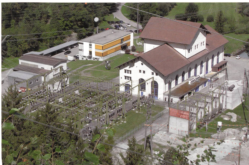
Das Unterwerk Sils Albula wird in den kommenden zwei Jahren erneuert.
