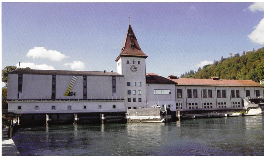
Die Konzession für das Wasserkraftwerk Aarau wurde erneuert.
