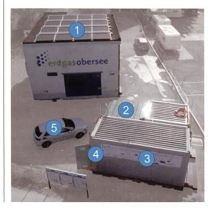
Übersicht Demonstrationsanlage. 1: Photovoltaikanlage; 2: CO<sub>2</sub>-Abtrennung; 3: Elektrolyse und Methanreaktor; 4: Tankstelle; 5: Erdgasfahrzeug.
