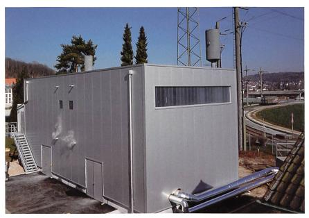
Die Power-to-Heat-Anlage in Niedergösgen hat eine Leistung von 22 MW.
