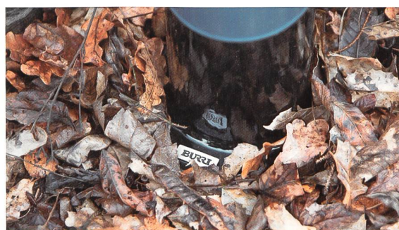
Stahlrohrkandelaber mit neuer Schutz-Beschichtung BURRI ROOTPAKK HMR coating.
