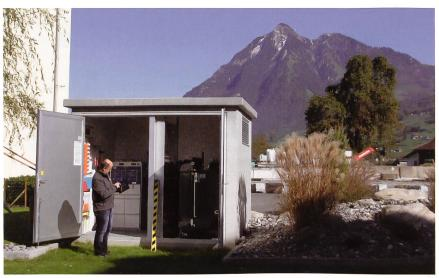
Bild 2 Inspektion einer Transformatorenstation mit Tablet.
