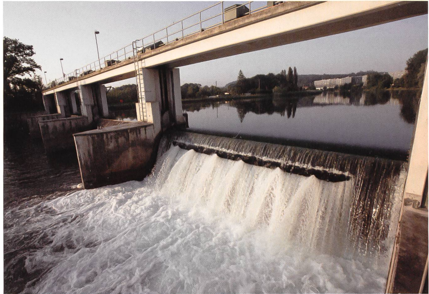
Das Wasserkraftwerk Dietikon soll ab 2018 während zweier Jahre für rund 43 Millionen Franken erneuert werden.
