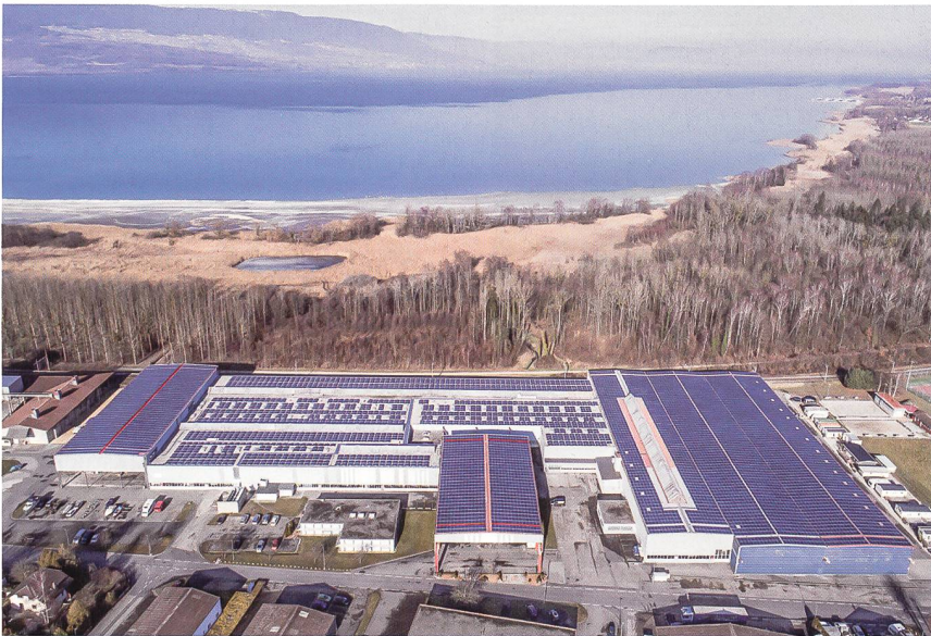
Le plus grand parc solaire de Romande Energie. Les panneaux ont été installés et raccordés en 4 mois seulement, un temps record pour ce type d'installation.
