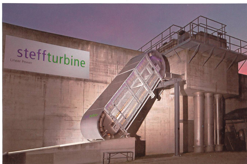
Steffturbine in der Kläranlage Step La Saunerie, Colombier.
